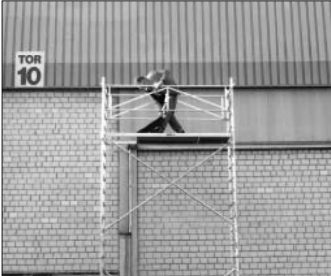
17. Den zweiten Geländerrahmen (5) ebenfalls einhängen.
