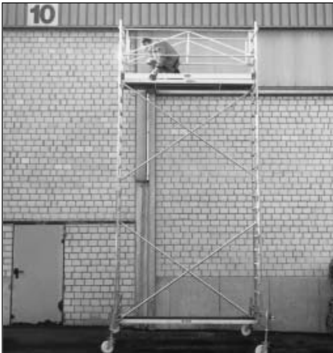
19. Bordbrett (11) beidseitig anbringen. Die Stirnbordbretter (12) werden an den Beschlagteilen in die Bordbretter (11) eingesteckt.
