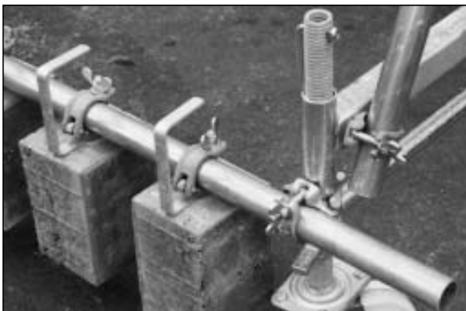
21. Ballastgewichte entsprechend der Ballasttabelle auf Seite 5 und 6 anbringen. Ballastgewichte so nah wie möglich in den Bereich der Spindel anbringen.
