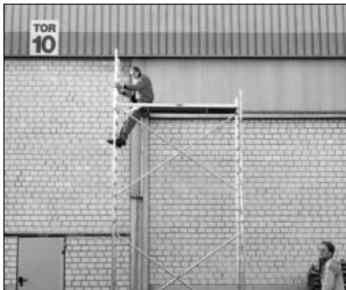
14. Leiterrahmen 1,00 m (2) auf die Leiterrahmen 2,00 m aufstecken.
