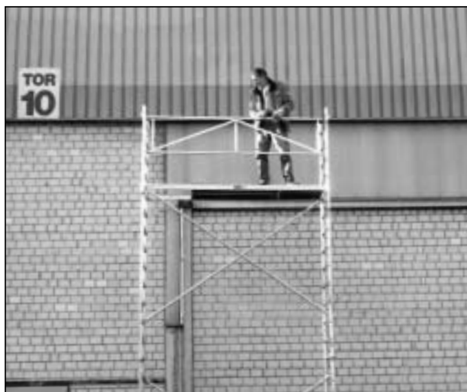
16. Geländerrahmen (5) in die oberste Sprosse der Leiterrahmen 1,00 m (2) einhängen.
