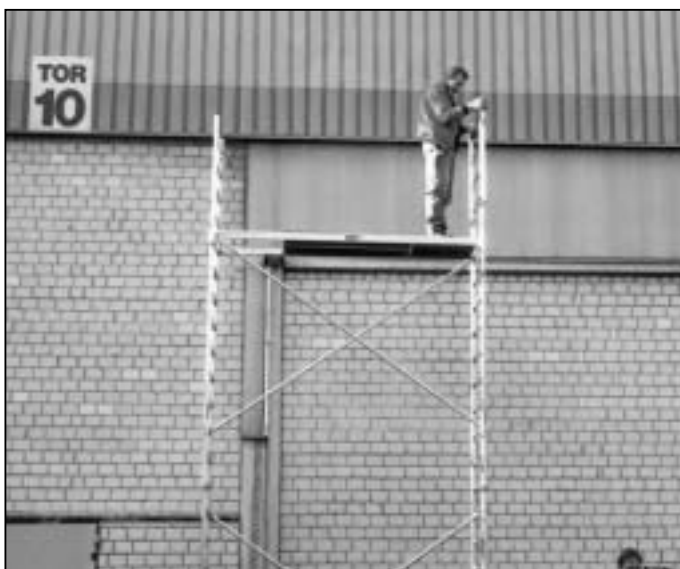
15. Den zweiten Leiterrahmen 1,00 m (2) ebenfalls auf den Leiterrahmen 2,00 m (1) aufstecken.
